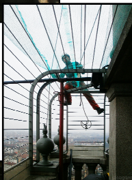
Il montaggio delle reti di protezione sulle gabbie di sicurezza
